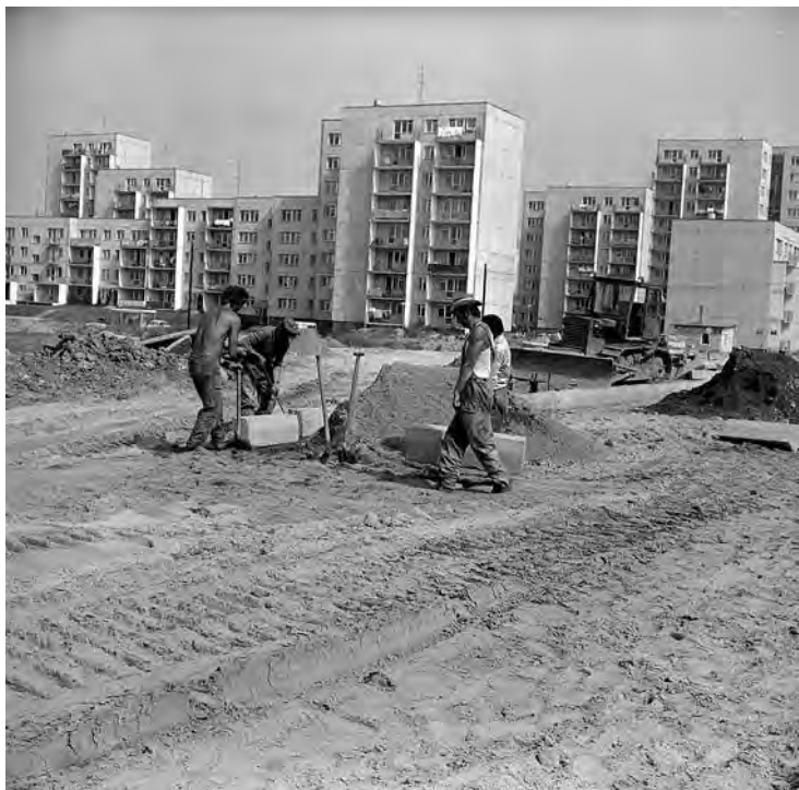
Budowa osiedla. Robotnicy układają krawężnik. Widoczny spychacz gąsienicowy i stojące obok butelki wina. W tle gotowe bloki mieszkalne, do których łąda chwilą wprowadzą się pierwsi lokatorzy. Autorka: Grażyna Rutowska / Źródło: Narodowe Archiwum Cyfrowe
