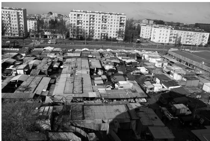
„Zieleniak” widziany z okolicznego budynku niedługo przed wejściem spycharek. Fot. Michał Sierżputowski
